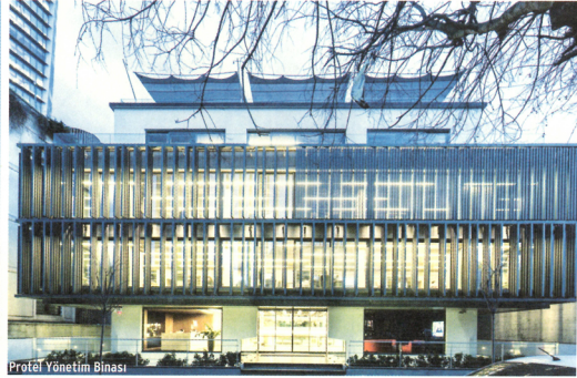
Profel Yönetim Binası
